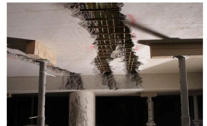
6 Instandsetzungsmaßnahme entlang eines Trennrisses (Quelle: IB Schieß Gehlen Sodeikat GmbH)
